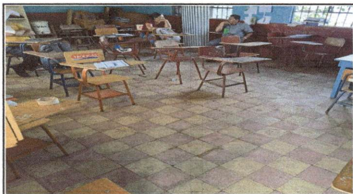
Foto 3: SUSTITUCIÓN POR PISO CERÁMICO
