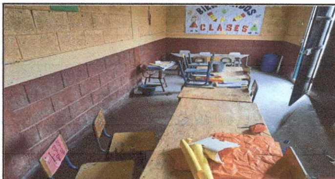
Foto 6: SUSTITUCIÓN POR PISO CERÁMICO
