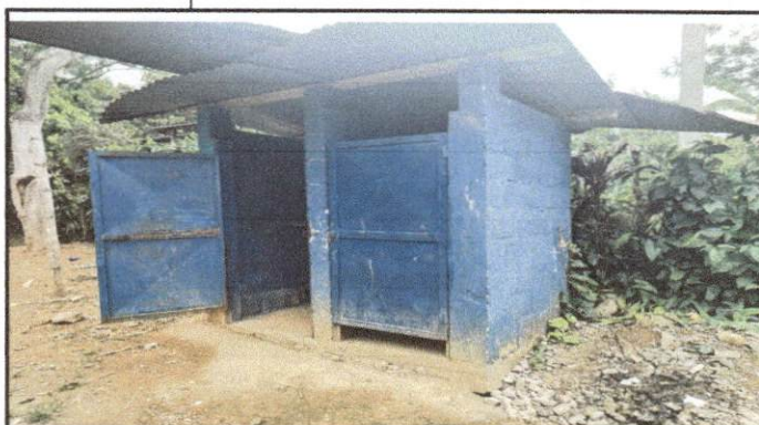
Foto 2: SUSTICIÓN DE LAMINA POR LAMINA TROQUELADA, REPELLO MURO, SUSTITUCIÓN DE ELEMENTOS DE FIJACION, SUSTITUCIÓN DE ESTRUCTUTRA DE SOPORTE DE MADERA POR METAL
