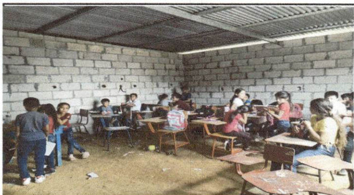
Foto 1: SUSTICIÓN DE PISO CONCRETO
